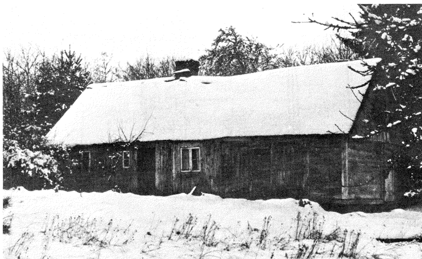
Fig. 11. Skånsk jordstuga i omålat skiftesverk i Röshult, Hörja sn, Skåne. Foto 1972, LUF.
