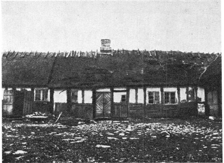
Fig. 10. Boningslänga. Övre fack fyllda med kline och undre med "bålar" (skiftesverk). Björstorp, Brösarps sn, A. Foto tidigare än 1903 (ur Nilsson, Övergångsformer).
