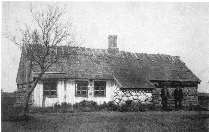
Fig. 14. Boningshus med panel- och halmklädda ytterväggar. Örum, Hörups sn, I. Foto 1920-talet, LUF.
