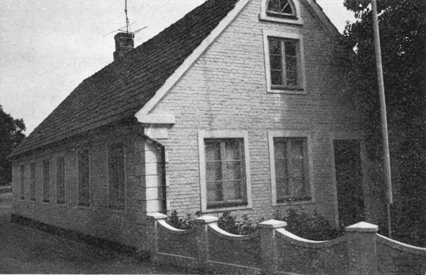
Bild 32 Bojen 2 , från 1860. Samme byggmästare som Slupen 2 . Gulmålad tegel och putskvadrar på knutarna. Foto 1969.
