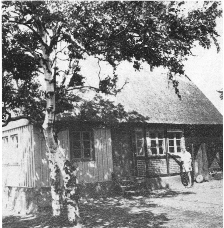
Bild 26 Framtagning av övertäckt korsvirke med såväl timra som fyllningar väl bevarade. Delfinen 5. Foto 1957, ägaren.
