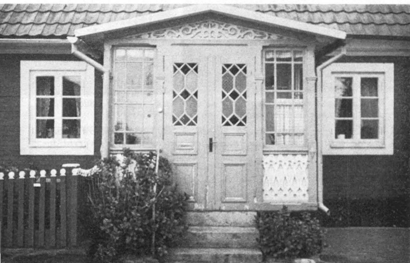
Bild 45 En sekundär, inglasad träveranda (med färgade glas) på Kvarnen 6. Foto 1967.
