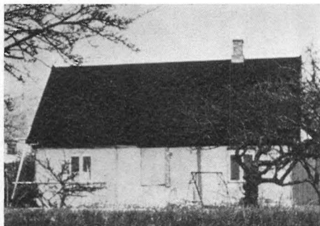
Bild 67, 68, 69 Typiska exempel på "restaurering" av ett brädklätt korsvirkeshus. I många fall kan det färdigrestaurerade huset betraktas som helt nytt. Foto Sune Sundahl, 1961—65.
