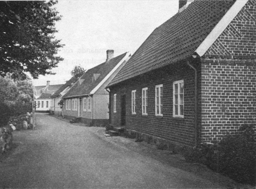
Bild 36 Mönstermurat tegel. Ejdern 7, byggd ca. 1860. Foto 1967.
