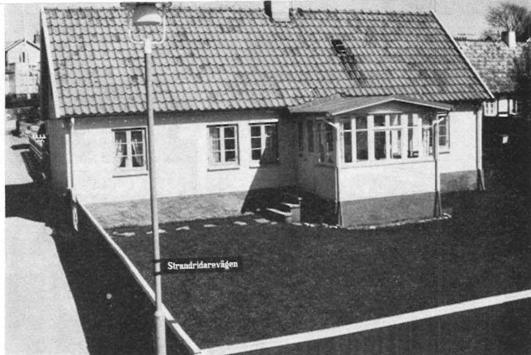
Bild 44 En sekundär veranda på murad sockel, på en reveterad korsvirkesbyggnad. Förmodligen tillkommen först på 1920—30-talet. Foto 1971.
