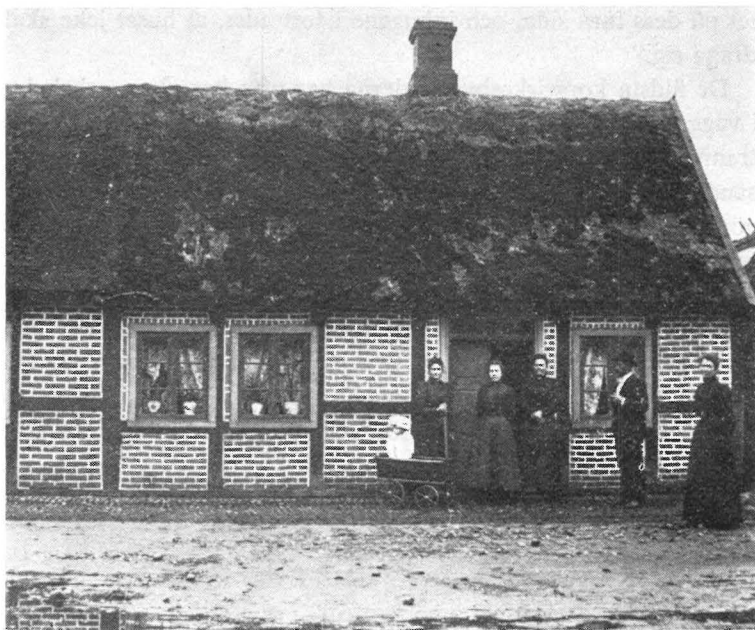
Bild 17 En för Viken typisk korsvirkesbyggnad med rödmålad timra och röd tegel i facken. Denna byggnad, som är ett av de mest välbevarade korsvirkeshusen i Viken, ser idag praktiskt taget likadan ut som på fotot. Taket är nu av eternit och dörren har bytts ut. Fönstren är desamma, men har målats vita. Svanen 5, uppförd 1805, tillbyggd 1865. Skeppare Ludvig Andersson med familj. Foto från sekelskiftet.
