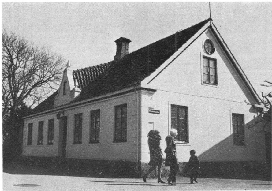
Bild 35 Kölen 1. Enligt uppgift ritad av samme arkitekt som svarade för ritningarna till Kulla Gunnarstorps slott och uppförd av samma sorts tegel som användes vid slottsbygget. Teglet är nu endast synligt i strömskiftet under takfoten. Byggnaden har vitputsats på 1900-talet. Foto 1971.
