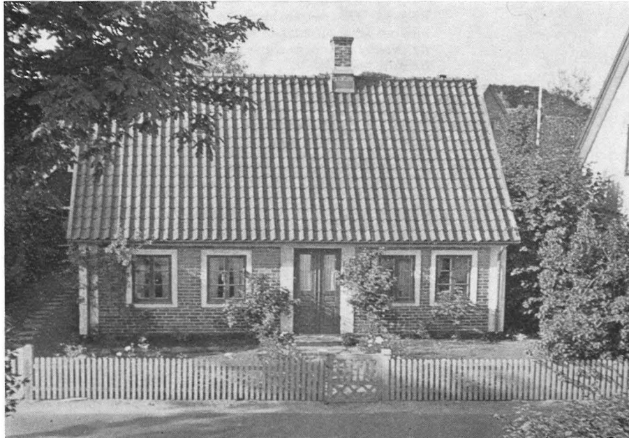
Bild 31 Ett välbevarat exempel på den typ av byggnader som förr kanske var allra vanligast i byn, med väggar i fogstruken tegel och schabronger, dörrfoder och knutar i slät vit puts. Kompassen 3, förmodligen uppförd 1871. Foto 1967.
