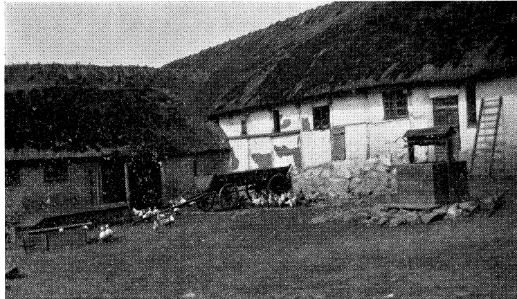
Uthuslängor i gamla prästgården i Gärdslöv, nu rivna. Byggnadssättet med korsvirke och klineväggar var detsamma som förekom i bondgårdarna.
