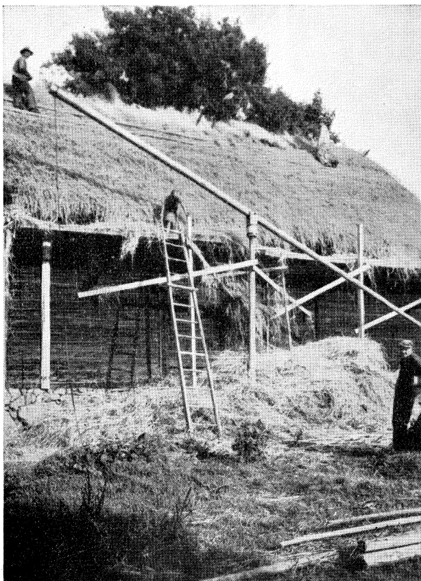
70. Bindning av halmtak. Postgården i Århult, Ålems sn, Stranda hd, Småland. Halmen föres upp på taket medelst en brunnsvippliknande hissanordning. Foto M. Hofrén 1940.
