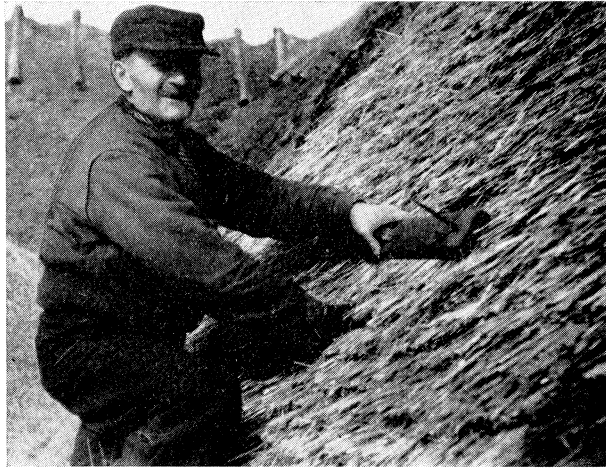
17. Taktäckaren har just lagt taket och håller på med nerskärningen. Han håller skärebrädan i sin vänstra hand. Kniven i den högra döljes av halmen. Taktäckning å Almdala, Dagstorps sn, Harjagers hd, Skåne. Foto Bengt-Arne Person 1957.
