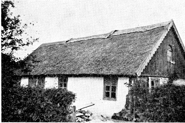
35. Cementryggning med stålträdsarmering, synlig i den träsiga nedre kanten. Foto åt nordväst. Taket av vassrör. Västsydväst om Gualövs kyrka, Villands hd, Skåne. Foto förf. 1949.
