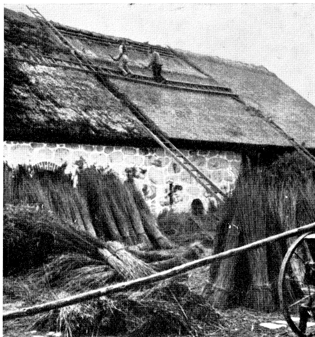
64. Täckning av ladugårdstak med vass. Två man under arbete med täckevrakan. På marken vasskärvar. Hästaryd nr 1, Mörrum sn, Blekinge. Foto Nordiska museet.
