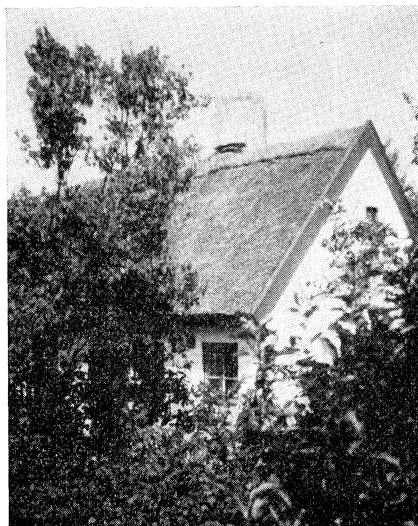
29. Hus å Slättaröds strand. Västra Karups sn, Bjäre hd, Skåne. Ryggning av "svär". Foto I. Ingers 1947.
