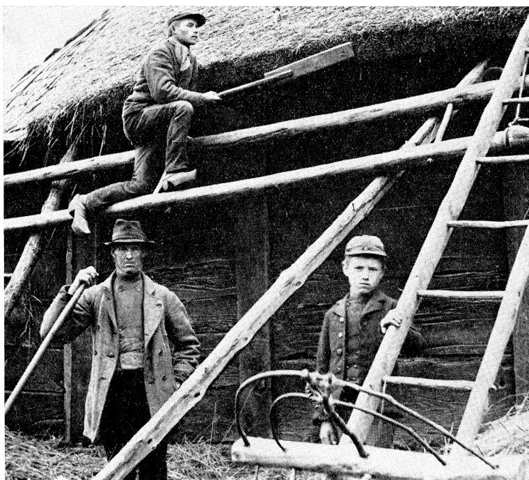
15. Taktäckning i Perstorp på 1890-talet. Man ser taktäckaren på tvärstien i arbete med täckevrakan. Tvärstien hänger i rep och vilar på tvenne stänger på lut mot väggen. Nedanför står uppassaren med sin tjuga. Längst t. h. "göingastien" med en "bue" för transport av halmen upp på taket. Foto: Per Stjernberg. Kulturhistoriska museet.
