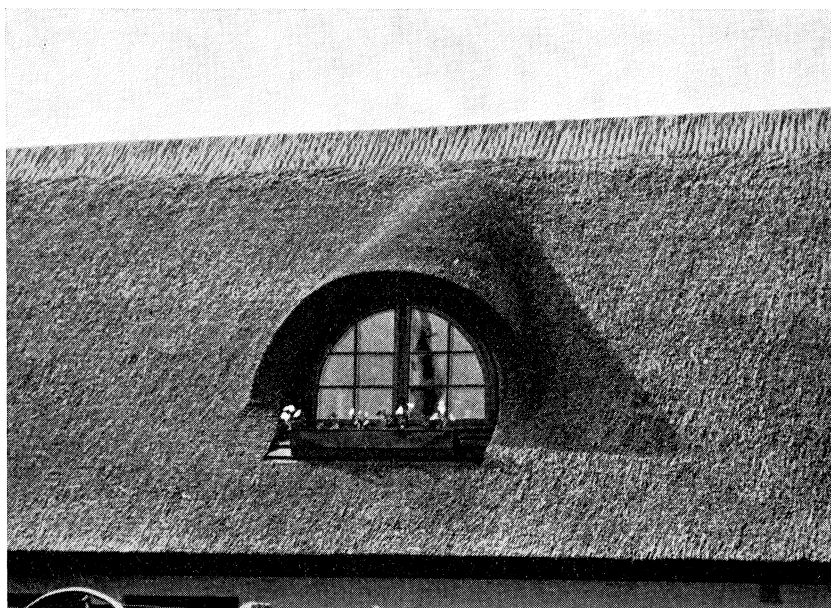
Vasstak med dockning. "Ost-Hansen"s villa i Bjerred, Torna hd, Skåne. Foto ägaren 1959.
