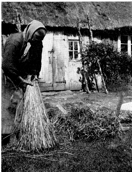
7. Långhalmen "göres upp". Man tog en "fätt" i sänder, stubben stöttes jämn mot marken och lades i "hällaren", ett "vriöl", tills kärven blev lagom stor, då två band knöts om. Örkeljunga sn, N. Åsbo hd, Skåne. LUF.
