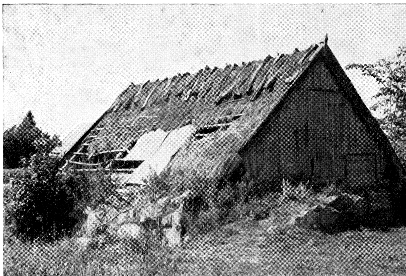
65. Halmtak på källare med tätt liggande ryggrän (kråkor). Valje nr 4, Sölvesborg, Blekinge. Foto Folklivsarkivet, Lund.
