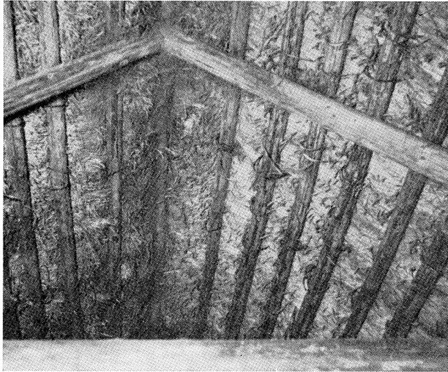
51. Insida av halmtak med vidjeband. Ögärdet, Liareds sn, Redvägs hd, Västergötland. Foto I. Vallin.
