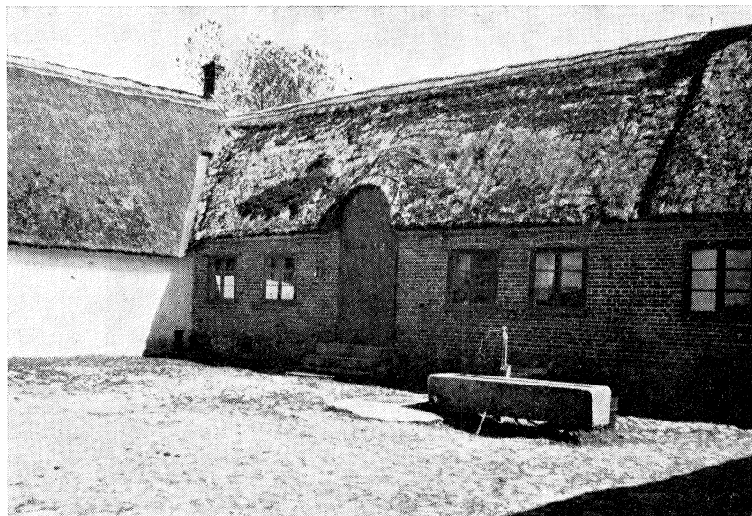
37. Tak på Ven med karakteristisk ryggning. Ernst Bengtssons gård. Tydliggen någon form av dockning med två rader raftar fästa längs ryggåsen. Foto Harald Olsson 1948.
