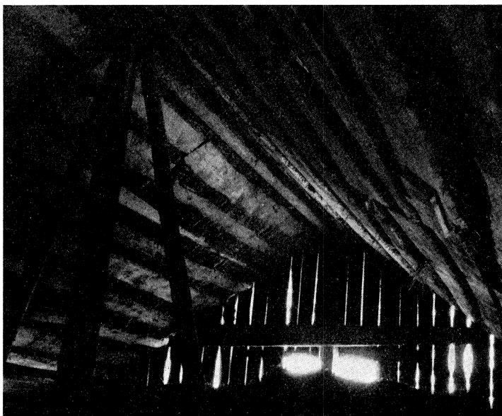
52. Timrad loge från 1600-talet med mycket grov timra. Barka nr 16, Gunnarsnäs sn, Nordals hd, Dalsland. Foto förf. 1955.
