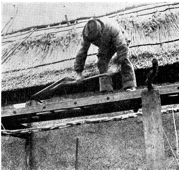
86. Halmtäckning av lada, Borg, Algutsrums sn, Algutsrums hd. Öland. Hofsen jämnas med täckevrakan. Foto M. Hofrén 1930.
