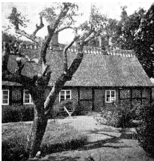
27. Ryggning med takpannor och ståltråd. Takpannorna hänga en på var sida av ryggingen som kvarhålles av den tvärsöver förlöpande tråden. Från gård i Simris sn, Järrestads hd, Skåne. Foto E. Brefelt 1947.
