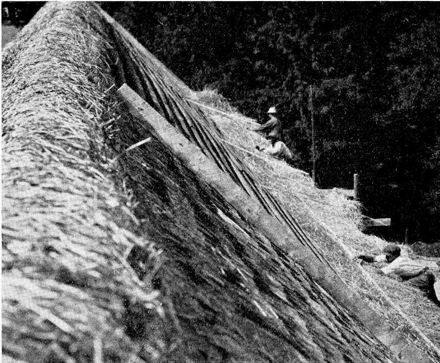
74. Omläggning av tak på Skattegården, Bäck by, Kånna sn, Sunnerbo hd, Småland. Hofsen lägges. Foto Nordiska museet 1934.
