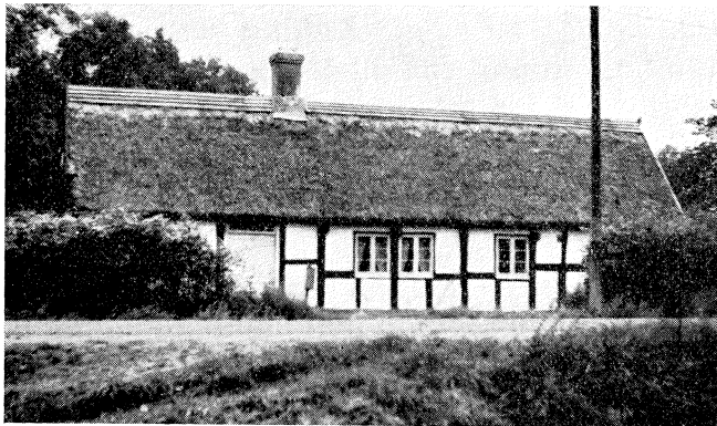
36. Ryggning med bräder. Böstofta 9, Gudmundtorps sn, Skåne. Foto förf. 1947.
