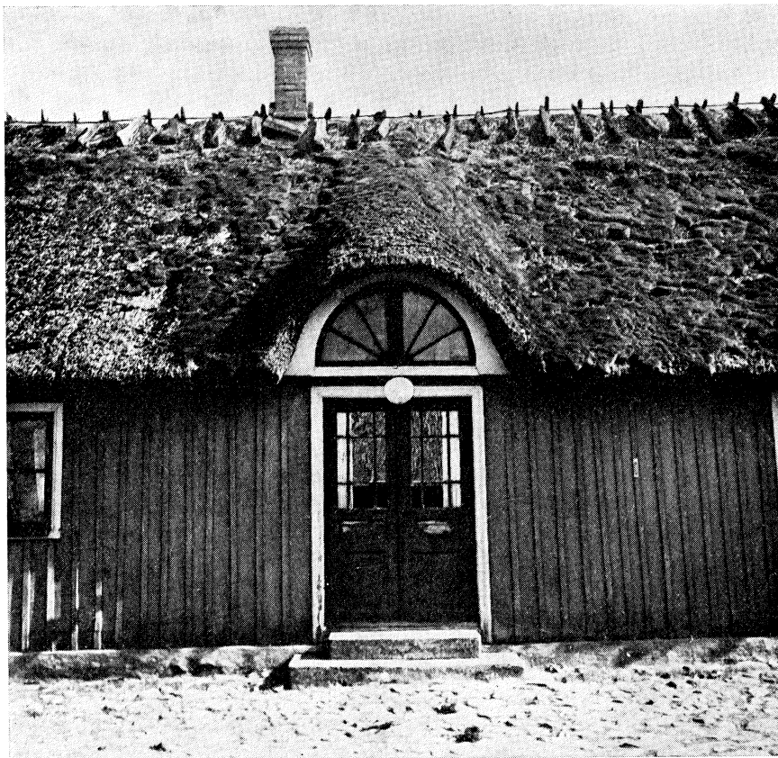
28. Lanternin, takkäpp (=ryggakäpp) och mossa på taket. Från "Teodors gård", Hörröds sn, Gälds hd, Skåne. Foto E. Brefelt 1947.
