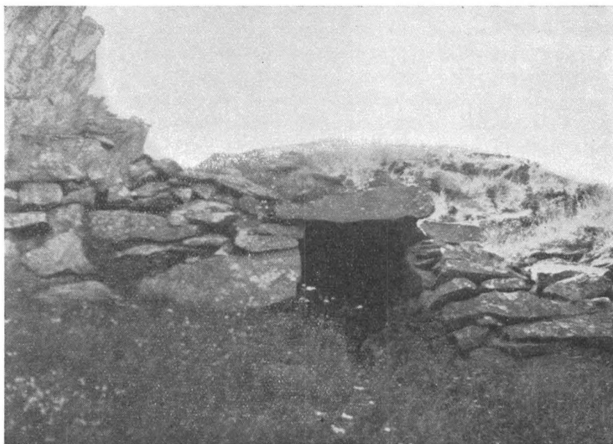
6. Överkragad kupolbyggnad, vilken tidigare använts som fårhus. Koön, Klövedals socken, Bohuslän. Foto av förf. den 14 juli 1947.
