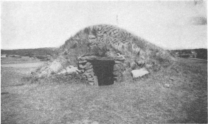
4. Källare med överkragat kupolvalv vid Rålanda Yttergård, Tegneby socken, Bohuslän. Foto av förf. den 27 juli 1947.
