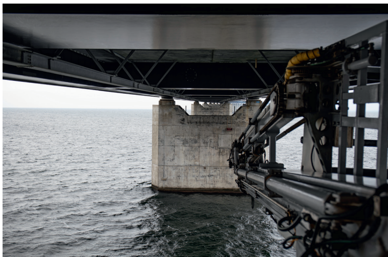
Per Brunsgaard Petersen, tekniker, och Christer Bennborn, inspektionsvagnsförare, arbetar med underhåll av Öresundsbron och de inspektionsvagnar som kör under bron.
