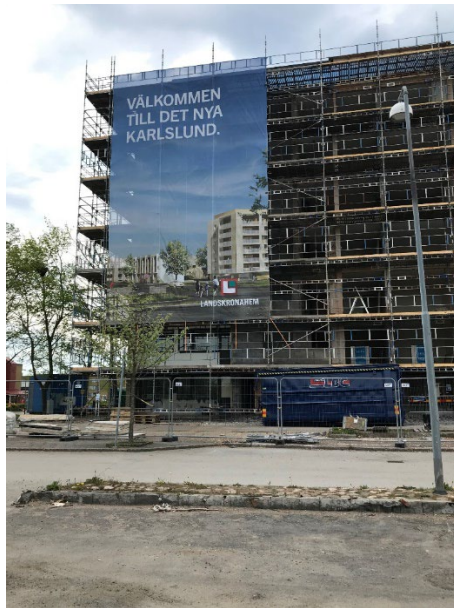
Figur 1: Omfattande renoveringar av bostäder i Karlslund, Landskrona. Foto: Författarna
