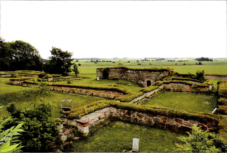
Fig. 70: Det sydöstra klosterområdet i Alvastra, sett från östra längan, vars södra del syns t.h. i förgrunden, med det lilla latrinhuset längst ned (t.h. i bild). Den mer välbevarade byggnaden med källarportalen är det s.k. Abbotshuset (Regners hus nr 5) och framför det i bild det ligger den östra innergården. Bortanför t.v. skimtar övriga byggnader (nr 3 och 4), vilka kan ha fungerat som infirmarier eller liknande. Foto den 17 juni 2011.
