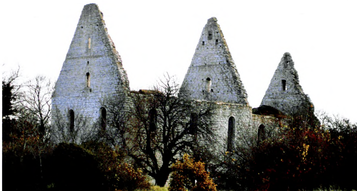
Fig. K68: S:t Görans hospitalsruin utanför Visby, sedd från sydväst. Foto den 12 november 2008.
